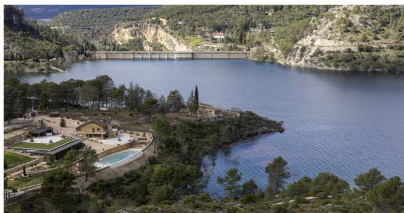
Entrepeñas está prácticamente lleno y por eso se ha abierto un canal que deriva agua a Buendía. / JAVIER POZO
